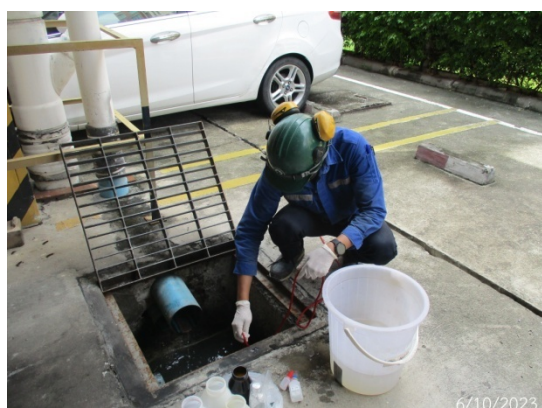
บริเวณบริเวณส่วนแยกตะกอนของระบบบำบัดน้ำเสีย ของอาคาร 13-1
